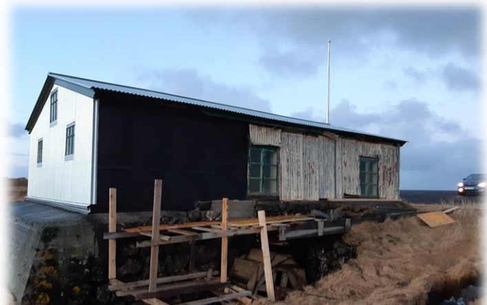
Rjómabúið á Baugsstöðum í desemberlok 2018 þegar framkvæmdir á austurhlíð voru hafnar.
