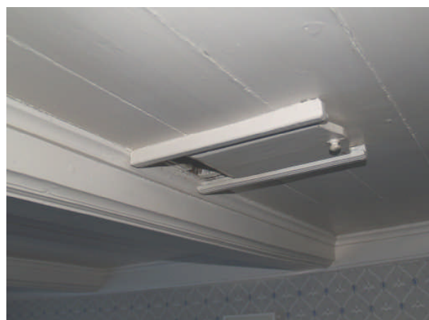
Húsið sjálft er aðal safngripur Byggðasafns Árnesinga. Þar gefur að finna þessa loftlúgu milli dætraherbergis á annari hæð og vinnumannaherbergis á hanabjálkalofti. Frá dætrunum fengu vinnumennirnir hita í gegnum þessa lúgu segir Ásgrímur vikaþilur Jónsson í bókinni Myndir og minningar.
